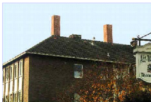
Hinter "Rauchfang" verborgene Mobilfunkantennen
