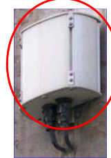
Mikrozelle, kleine Sektorantenne
