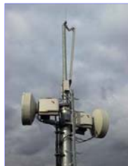
Richtfunk-Antenne
