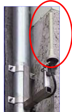
Mikrozelle, kleine Stabantenne
