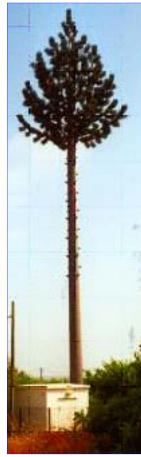
Antennenbaum in Portugal Verräterisch ist natürlich der BTS-Container, aber der Baum an sich ist gut gelungen.
